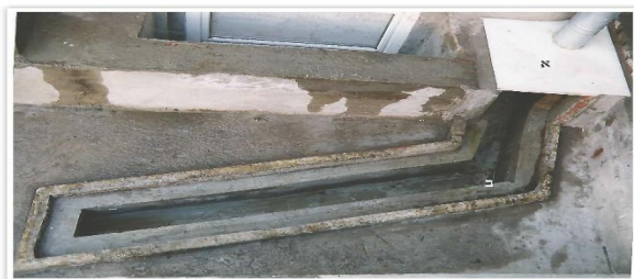
א. צינור המי גשמים מהגג ב. תעלת המשכת המים מהצינור לאוצר המים
